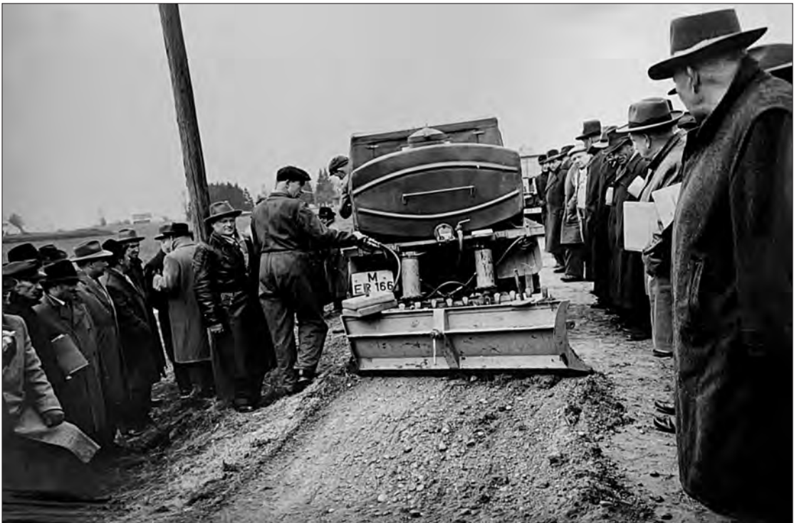
Wegebau Profiliergerät auf einer Vorführung durch Henne im Münchner Raum
