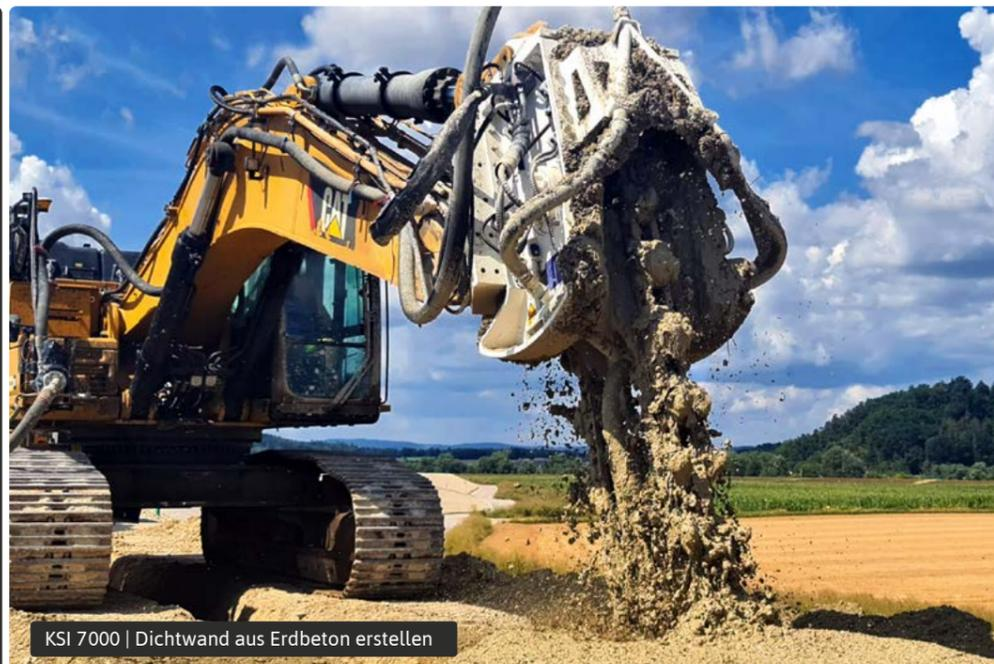
KSI 7000 | Dichtwand aus Erdbeton erstellen
