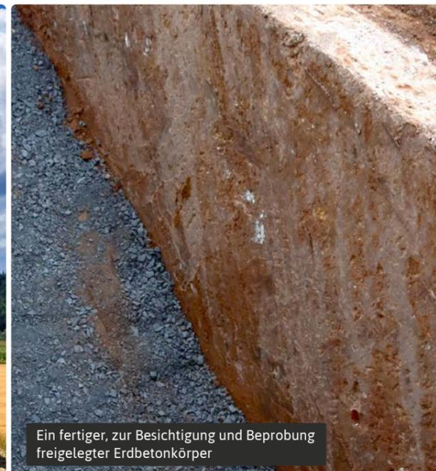
Ein fertiger, zur Besichtigung und Beprobung freigelegter Erdbetonkörper
